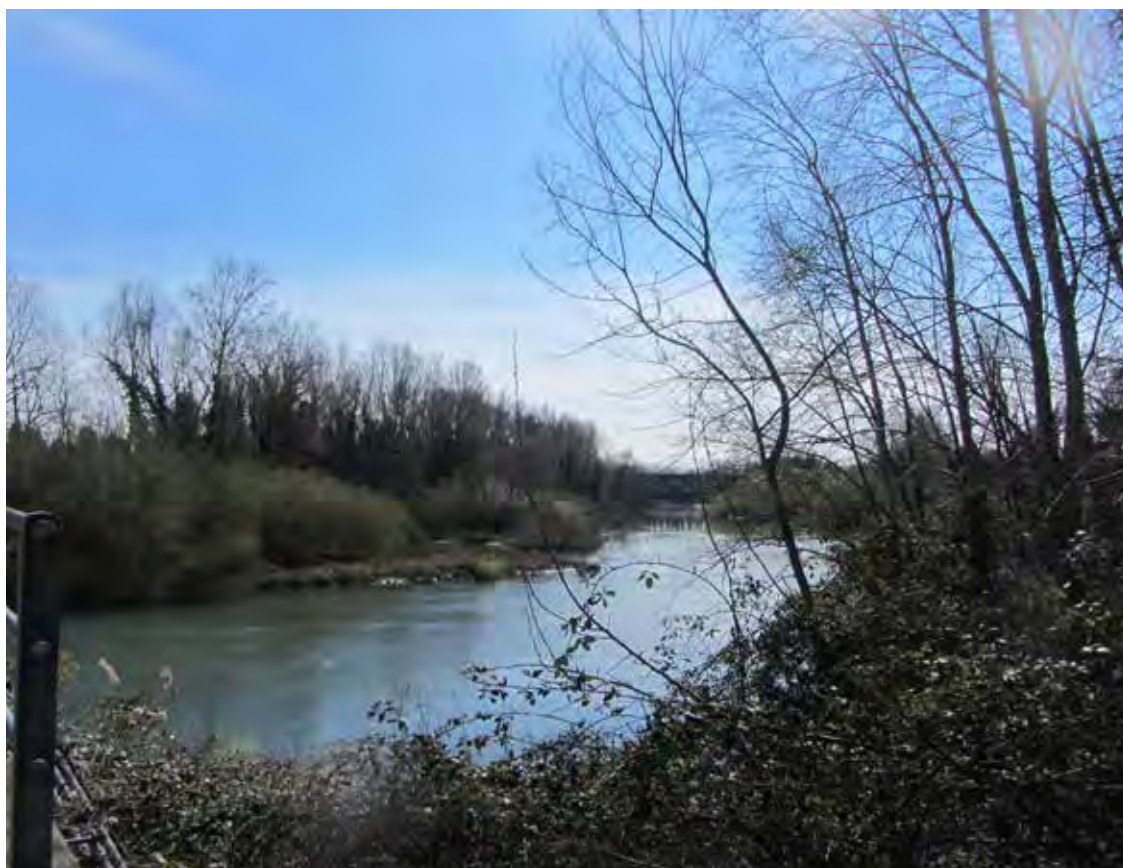
19. Il Fiume Stella nell'area in cui è stato rilevato il ponte della via Annia a Palazzolo (dal ponte moderno verso sud)
